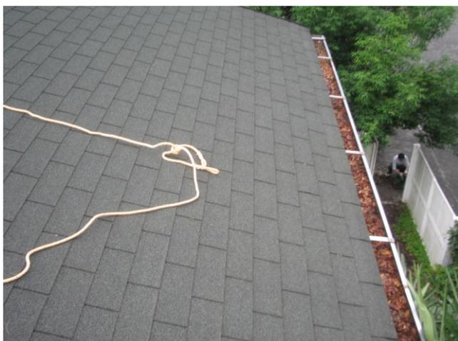
2階建て建物の屋根に付帯されている「雨どい」が落ち葉で詰まり、大雨が降ると屋根から雨水が大量に降り注いで通行人に支障があるとのことで、落ち葉除去の依頼です。
